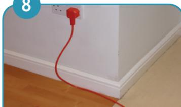
Das Kabel NICHT spannen, es soll stets locker am Boden liegen.
